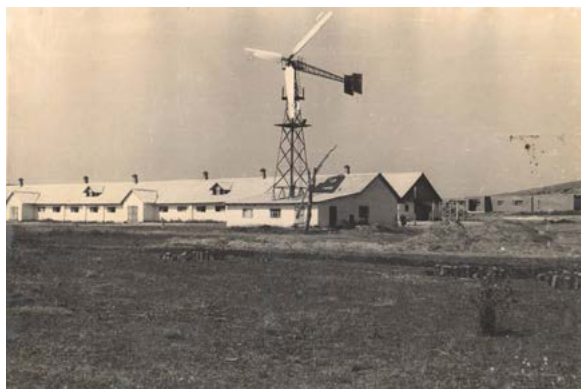
Instalația eoliană D-12 la ferma de vite din s. Horești, r-nul. Ialoveni, 1956 [22, f. 11].
