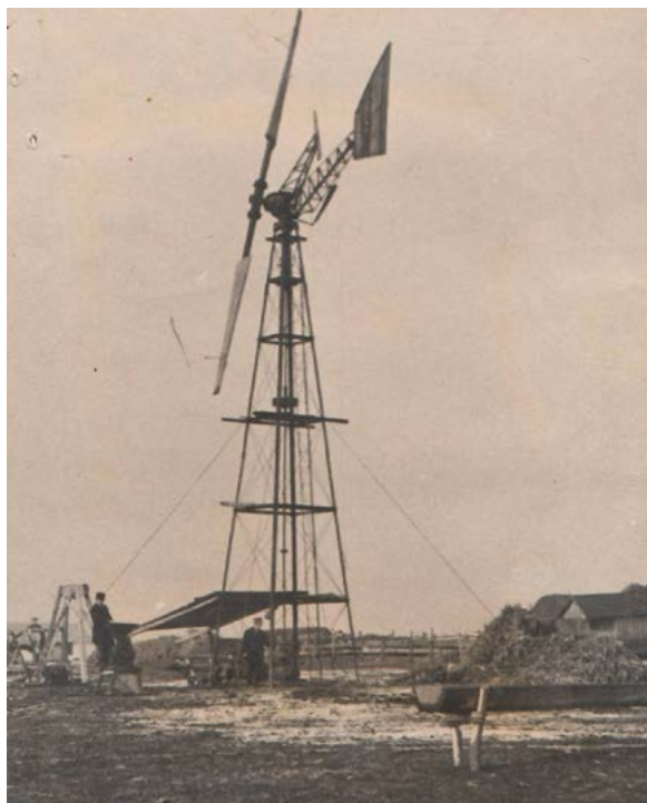
Instalația eoliană 2 UNDIM-D-10 la ferma de vite din s. Plopi, r-nul. Dondușeni, 1952 [3, f. 114a].
