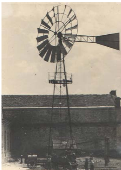
Instalația eoliană VD-8 utilizată pentru alimentarea cu apă a fermei zootehnice din s. Vladimirovca, r-nul. Râbnița, 1937 [22, f. 29].
