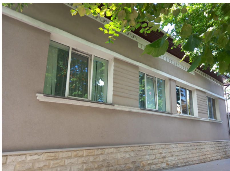
Fig. 4. Fosta casă de raport de pe str. Mihai Eminescu, nr. 53, foto Alla Ceastina.
