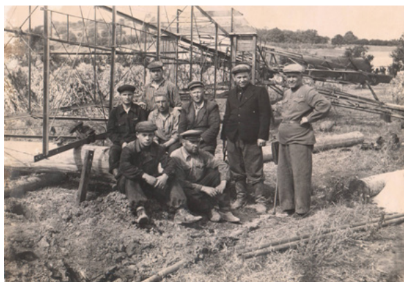
Asamblarea unei instalații eoliene de către un grup de muncitori, anii 1950 [22, f. 8].
