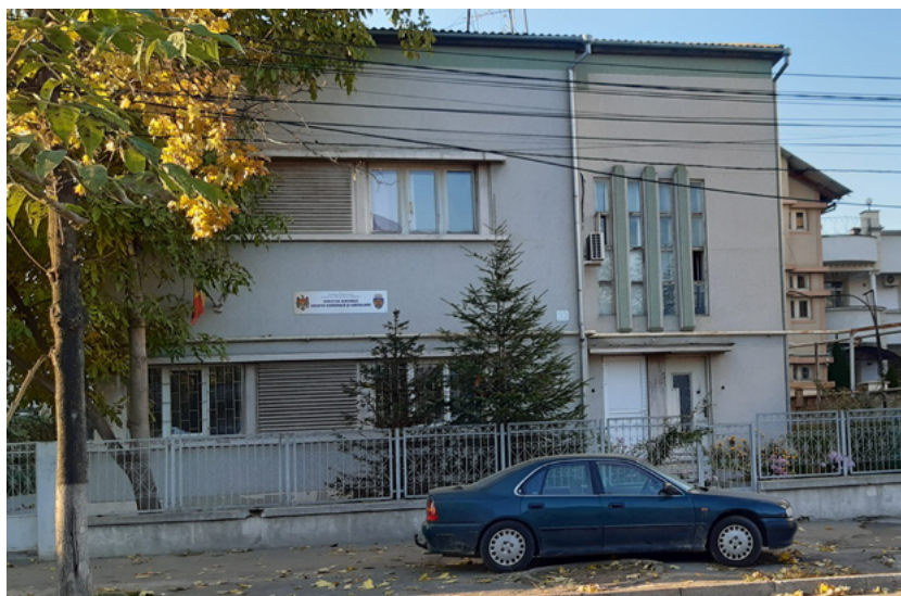
Fig. 2. Fosta vilă urbană de pe str. M. Eminescu, nr. 33, foto Victor Şlapac.
