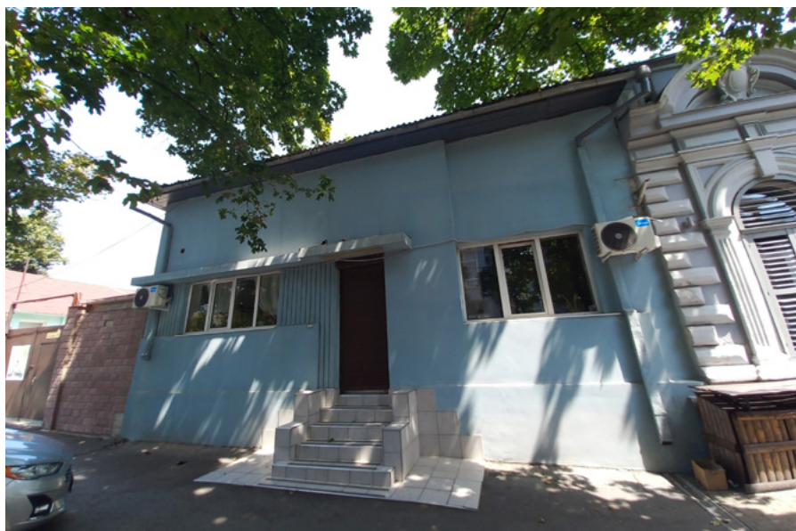
Fig. 5. Fosta vilă urbană de pe str. Veronica Micle, nr. 4, foto Alla Ceastina.
