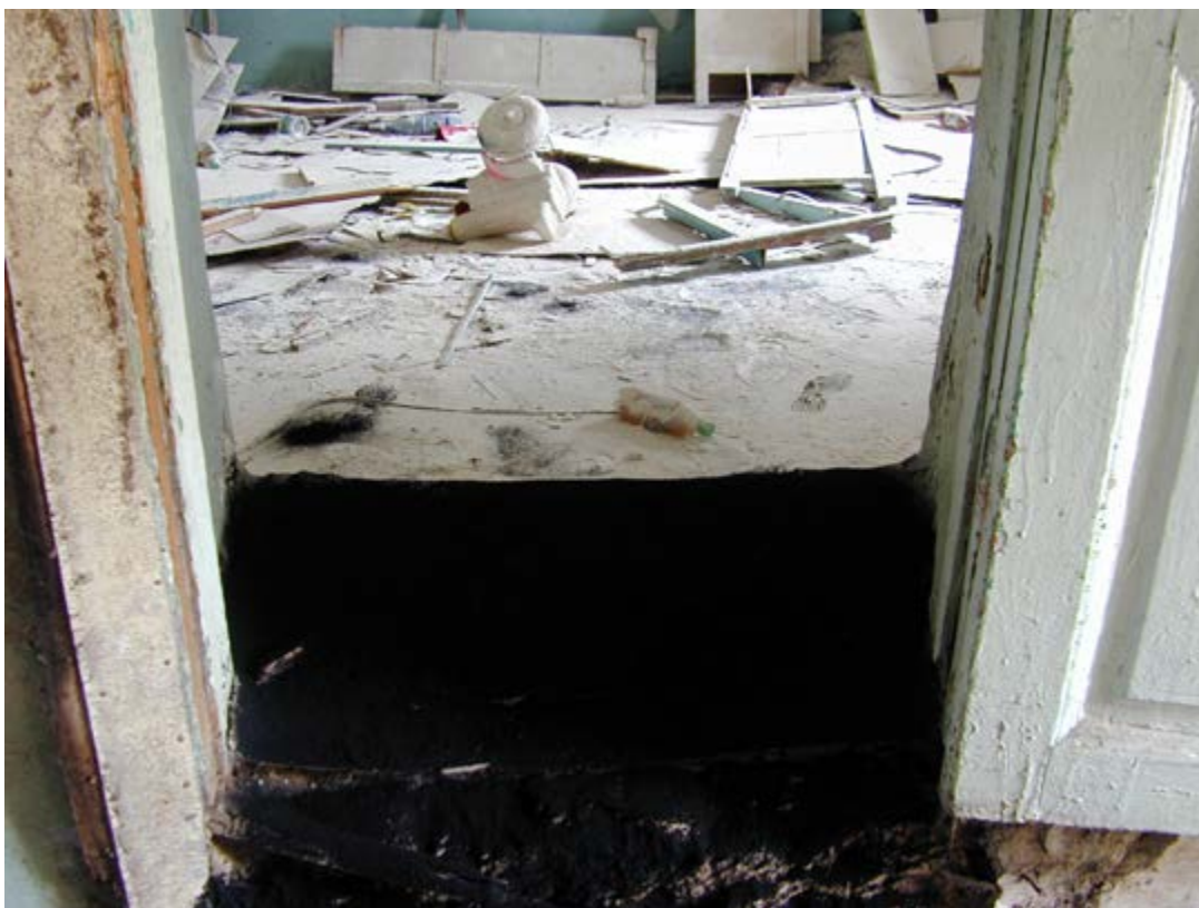
Iurie Ermurachi, instalație în clădirea fostei fabrici de bere Bohemia din Chișinău, „Cityscape”, 2004. Foto: Iurie Ermurachi.
